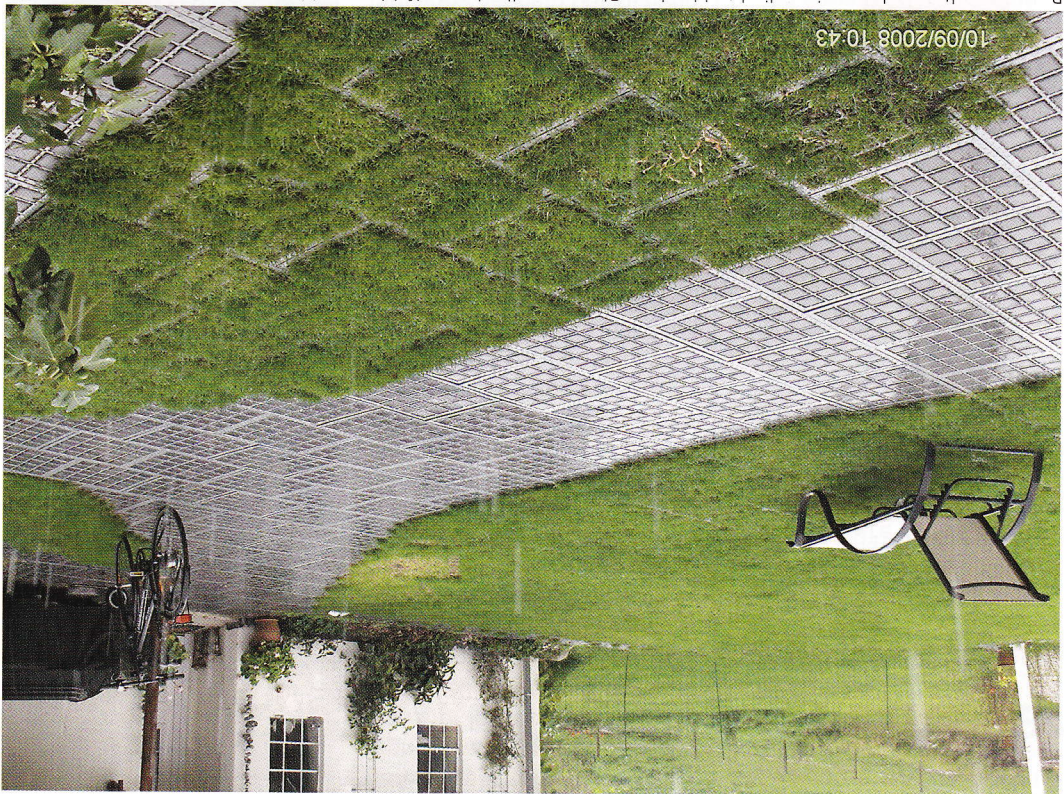
Regnen vælter ned - og silver direkte i jorden. Gittrenes celler kan udfyldes med betonsten eller med græs.
