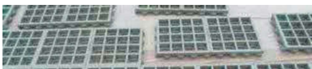
Lægning af TTE®-elementer på finmasket net (montagehjælp)
