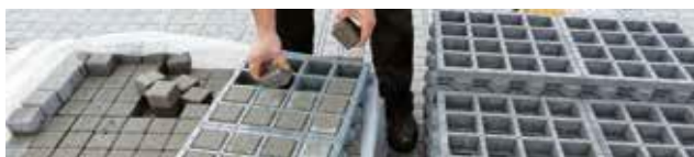
Kopstenen anbringes i TTE®-elementet
