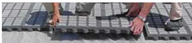
Man skal være to om at lægge de fyldte TTE®-elementer
