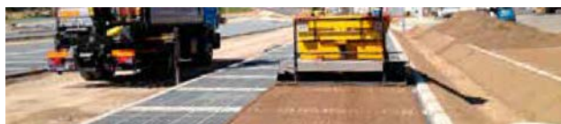
Bagfyldet anbringes med en udlægningsmaskine
