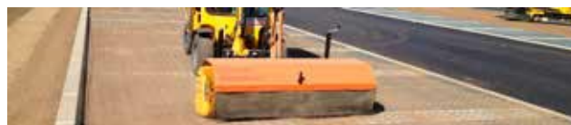
Underfyldet fremstilles ved hjælp af en fejmaskine
