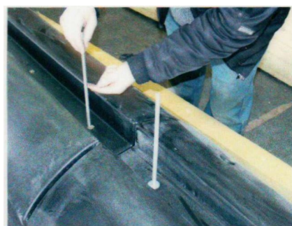
Montering af gevindstykker i topspor 10 x 10 cm.
