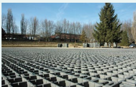
4000 m 2 ridebane hos rideakademiet i Ungarn med 50 % lukkede TTE®-gitter- blokke som vandreservoir (ca. 4 l/m 2 ).
