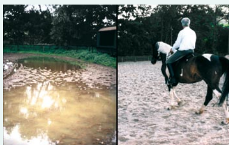
Let og ekstrem billig sanering: Ved hjælp af påbygning af 10 cm TTE®- dræn-bærelag på den komprimerede ridebane.
