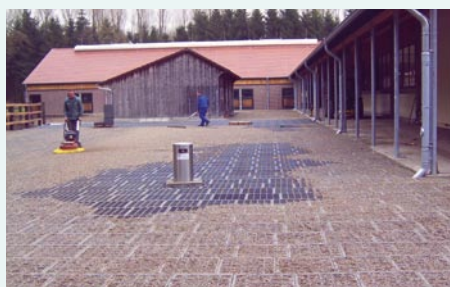
TTE®-indhegning, fyldt med grus, før udlægning af ridelaget.
