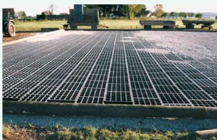
Naturlig uden traditionelt bærelag: Flad påbygning direkte på græsmarken med kun 5 cm vandret dræn med grus og TTE®-gitterplader .
