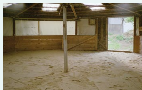
Let og ekstremt billig sanering: Ved hjælp af påbygning af 10 cm TTE®- dræn-bærelag på den komprimerede ridebane.
