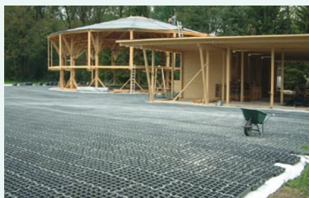
Jordbefæstelse i en løsdrift på græs jord (før fyldning)
