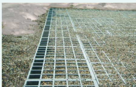
TTE®-systemet kan også udlægges på den frosne jord om vinteren.
