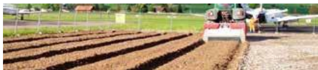
Vegetationsbærelag ved hjælp af jordbundsforbedring: Skærver arbejdes ind i den eksisterende overjord
