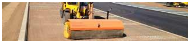
Underfyldet fremstilles ved hjælp af en fejmaskine
