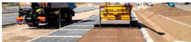
Bagfyldet anbringes med en udlægningsmaskine
